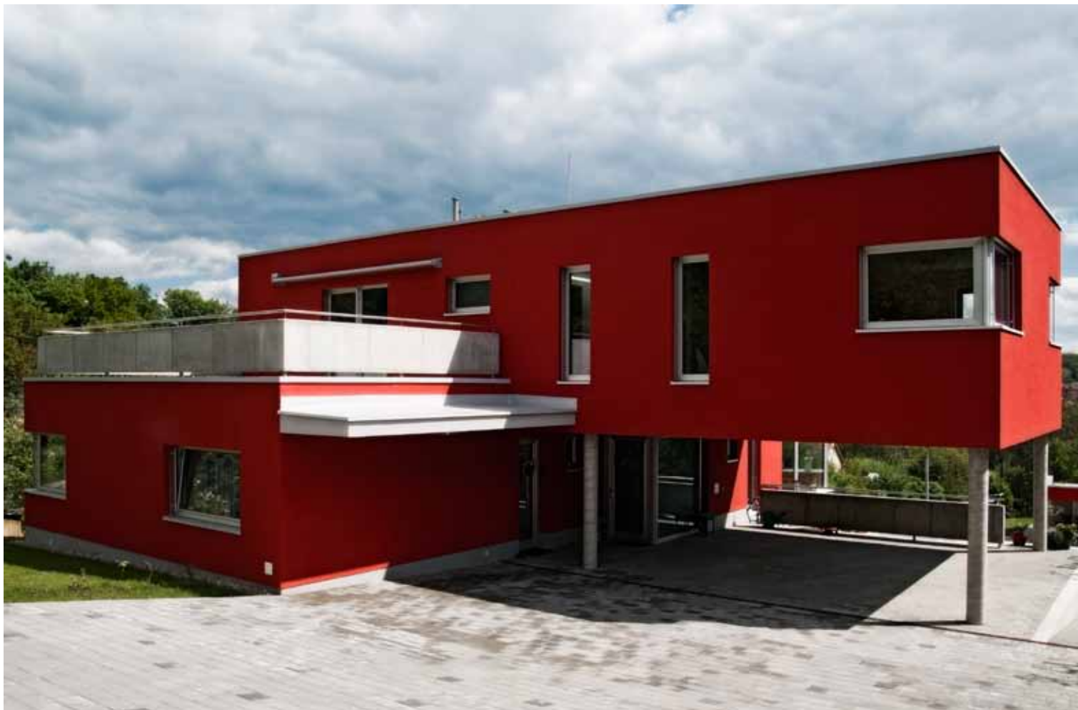
Přístup a příjezd k domu vede ze západní strany. Ložnicové patro podporují subtilní ocelové sloupky
