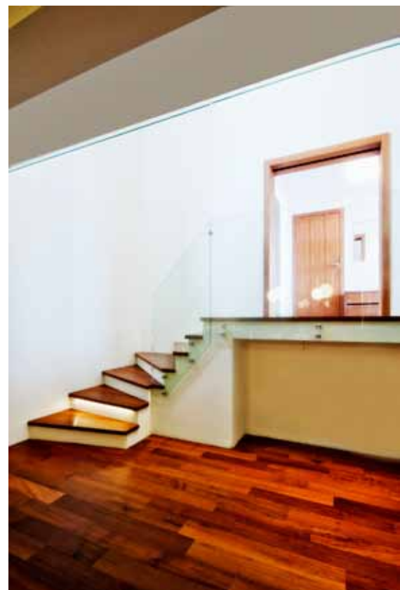
Dřevěná podlaha z merbau prochází přes schodiště až na galerii ve druhém podlaží
